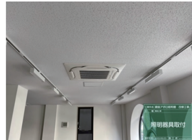
<電気・空調リニューアル風景>
