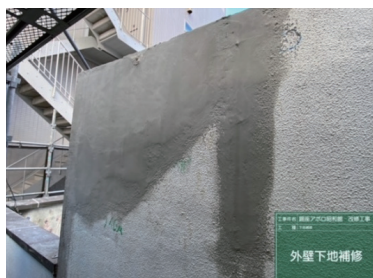
< 外壁剥離部分補修 >
