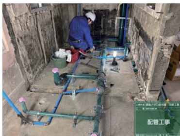
<給排水管リニューアル工事>
