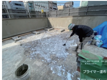
<屋上防水施工（速乾性吹付防水施工）>
