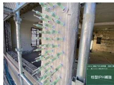
< 躯体 IPH 工法 > ※緑色の注射器のような器具で樹脂を注入
