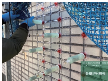
< 躯体 IPH 工法 > ※緑色の注射器のような器具で樹脂を注入
